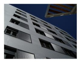
Renovación de la envolvente térmica del edificio. Aumento del aislamiento térmico. Ahorro energético. **Fachadas ventiladas** de cerámica, panel composite, tablero fenólico... Facilidad y rapidez de montaje.
